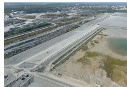
Rehaussement cellule B4
