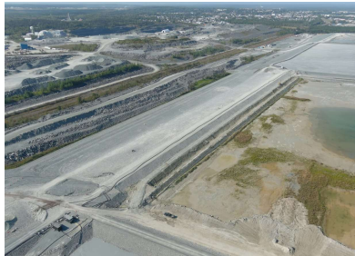
Rehaussement cellule B4
